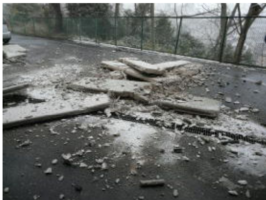
【校舎】登下校時，大勢の子ども達を通る場所。体育館の壁が崩れ落ちました
