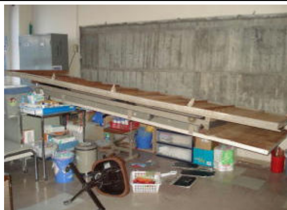
【校舎】倒れ落ちた保健室の黒板
