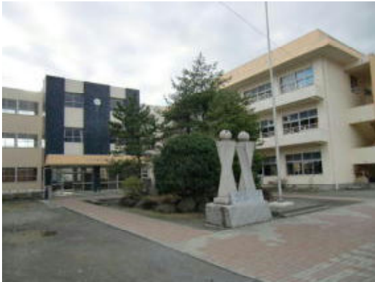
【校舎】耐震工事で大きな被害は免れました
