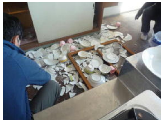
【校舎】家庭科室の食器類破損
